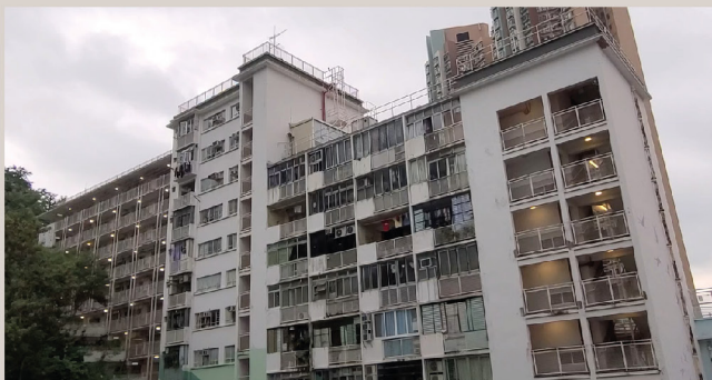
■ 西苑臺樓高 14 層，但升降機只達 9 樓，對長者甚為不便。
