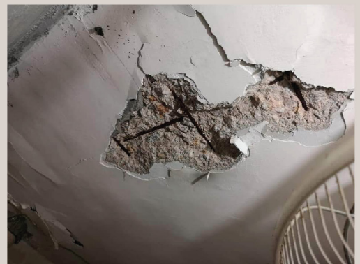
■ 單位出現石屎及天花混凝土剝落、鋼筋外露和漏水等結構性問題
