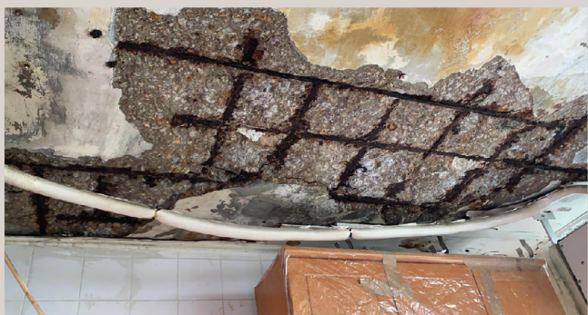
■ 2021 年 7 月，一位長者戶居住的單位露台天花有巨型石屎剝落，幸未造成傷害。
