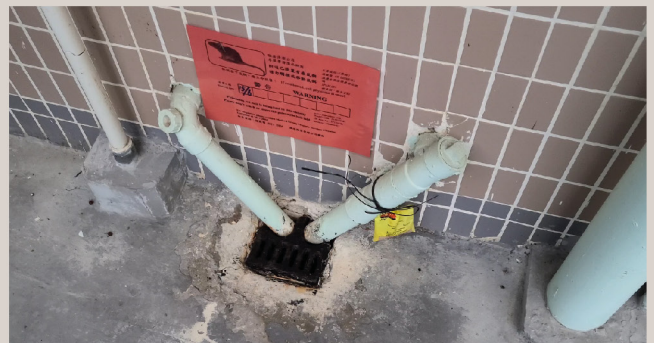
■ 屋邨單位天花普遍出現滲漏。屋外污水渠口無遮檔，老鼠甲由沿渠口爬入單位廚房。
