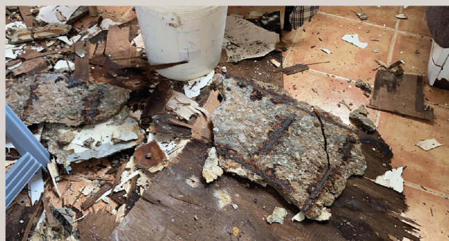
■ 2021 年 7 月，一位長者戶居住的單位露台天花有巨型石屎剝落，幸未造成傷害。
