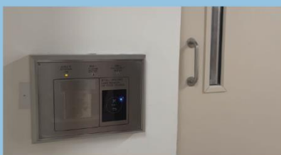
屯門顯發邨顯發樓安裝的智能門禁系統，大廈地下大堂及其他出入口均設有閱讀器/掃描二維碼。
